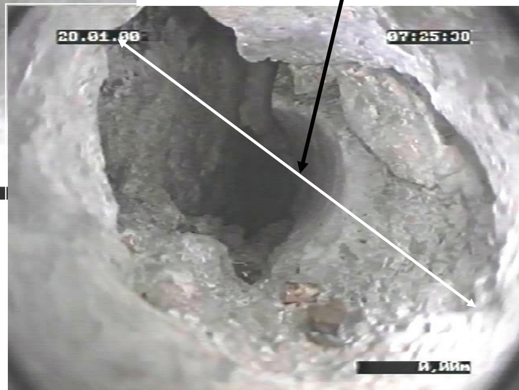
Elliptischer Ausbruch mit maximaler Erstreckung von etwa 25 cm
